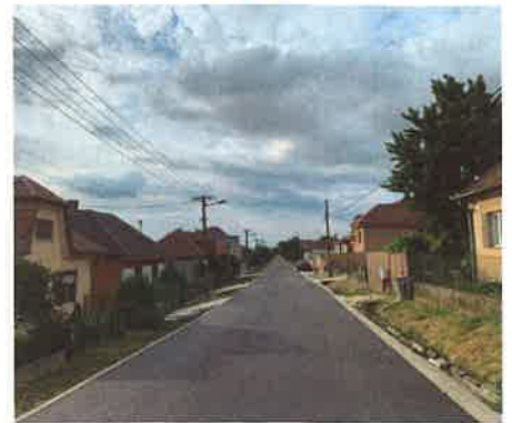
Rekonštrukcia Mierovej ulice
